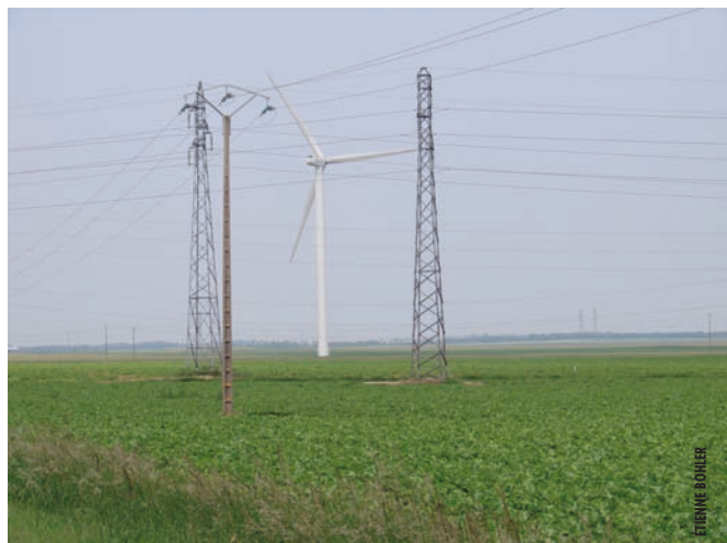
PYLÔNES, LIGNES TÉLÉPHONIQUES, ÉOLIENNES REGROUPÉES EN UN MÊME LIEU (LOIRET).
