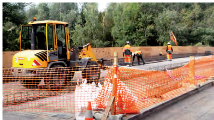
PRÉPARATION DU SOCLE POUR LES PANNEAUX ET DU FERRAILLAGE.
