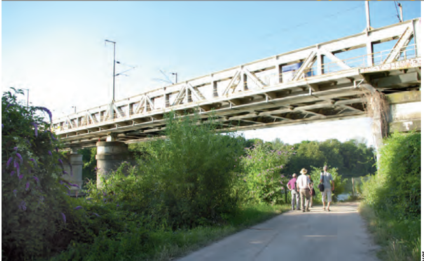
L'ACTUEL PONT FERROVIAIRE, ENJAMBANT LE CHEMIN DE HALAGE, DEVANT LEQUEL SERA CONSTRUIT LE PONT EOLE.
