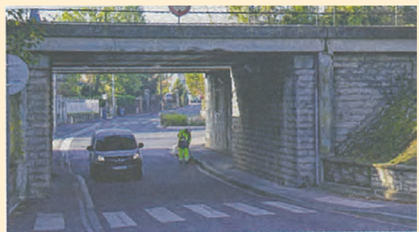
Le vieux pont-rail, âgé de 137 ans, commence à fatiguer...
