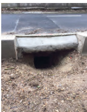
BUSE ENTRÉE D'UN CRAPAUDUC.
