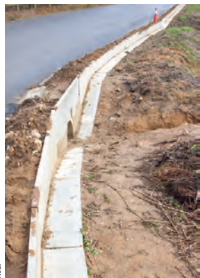
MURET CONDUISANT À LA BUSE.
