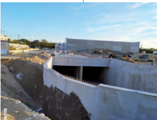
LE CHANTIER LUCIA.
