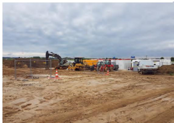
CHANTIER DE LA GARE EN 2021.
