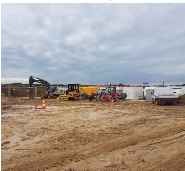
LE CHANTIER DE LA GARE.
